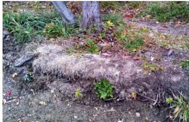
Figure 32: Eroded Pond Edge
